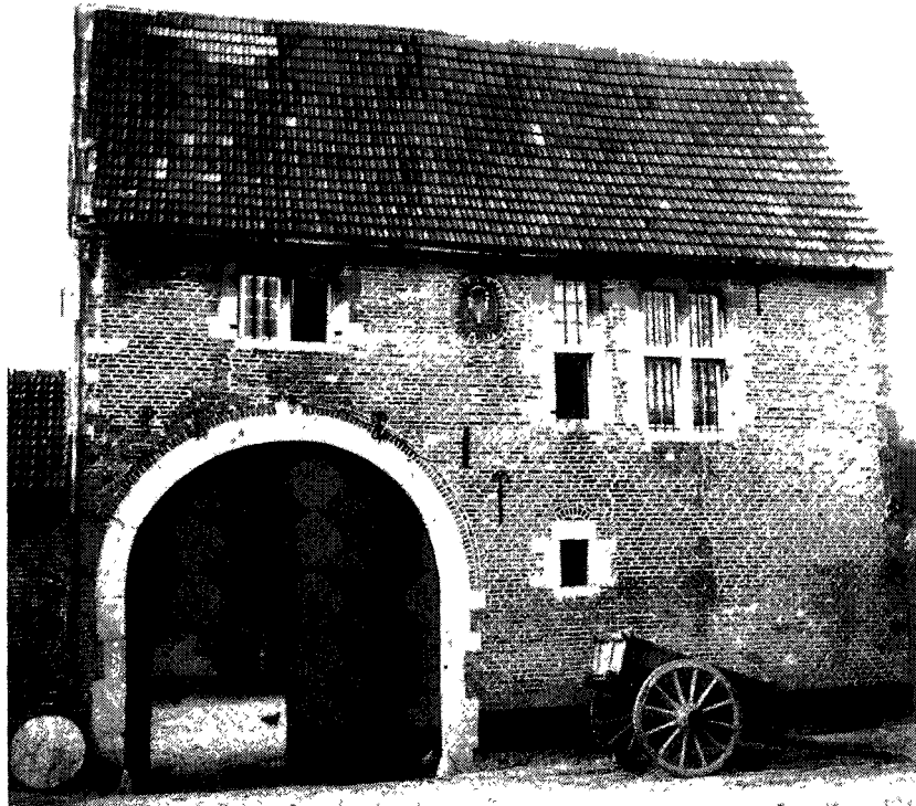
Afb. 52. poortgebouw van een hoeve waarbij de poort- en vensternebben met natuurstenen blokken versierd zijn (Borgloon)
