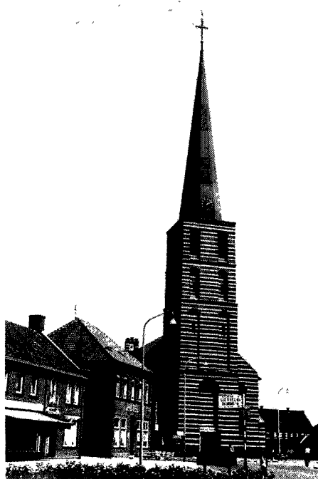
Afb. 44. speklagen in het metselwerk van de R.K. kerk in Meijel
